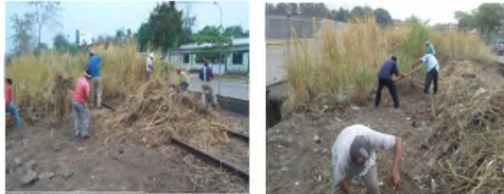
Vía Férrea de Plaza Galerías a Libramiento Sur
